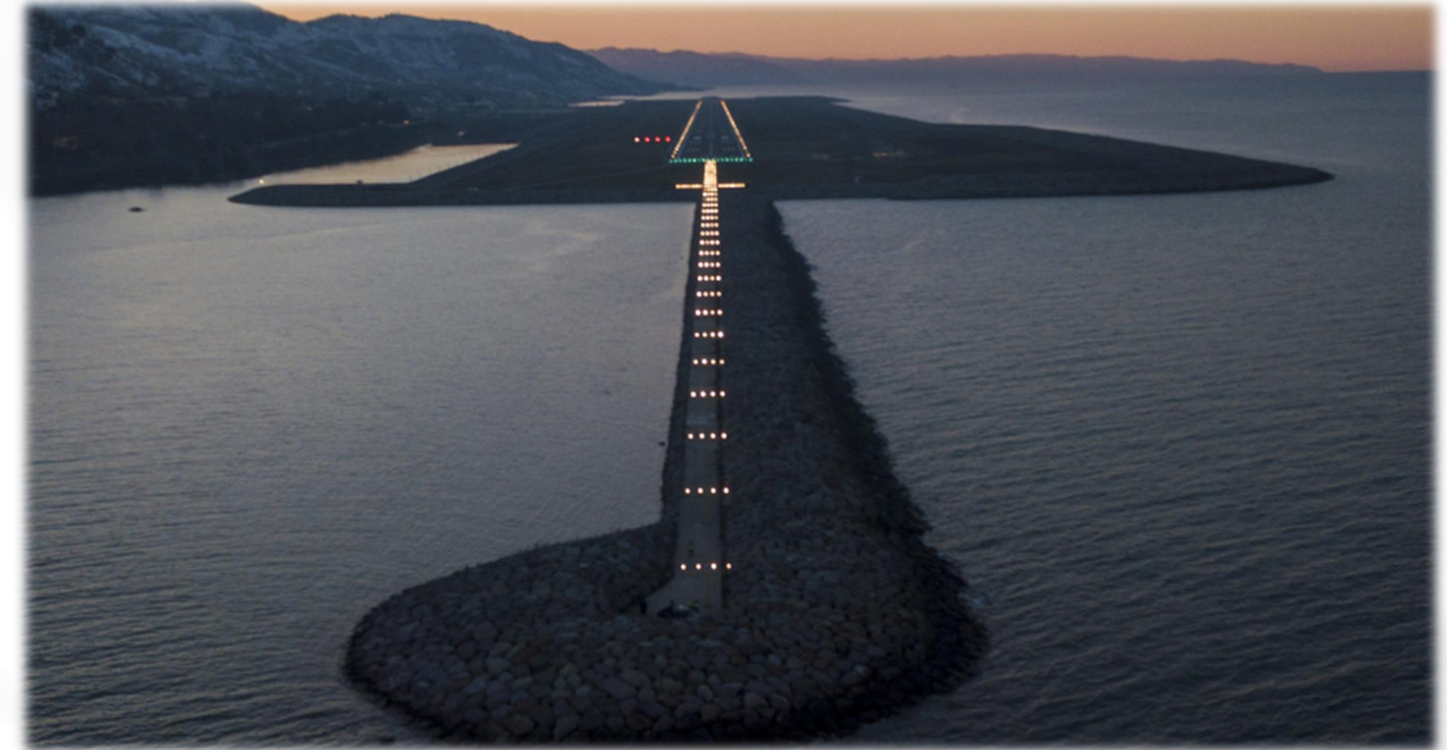
Deniz doldurularak yapılan Ordu – Giresun Havalimanı
