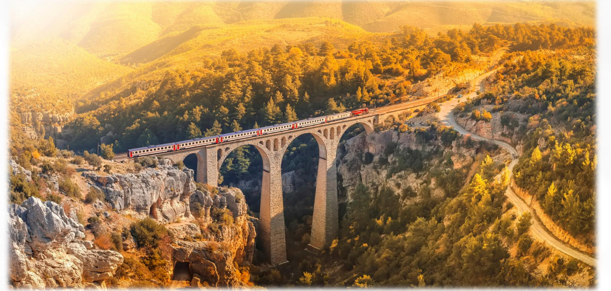
Demiryolu - Adana Varda Köprüsü
